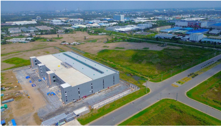
Hình 15: Hiện trạng KCN Long Hậu 03 (giai đoạn 01) với phần diện tích chưa hoàn thành GPMB
